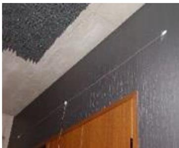
T型FMアンテナはアンテナ側をT字に張り、窓際の壁や、窓に水平に固定して張り付けます。アンテナ線を張る場所や方向、形などをいろいろと変えてみることによって、驚くほど受信状況が改善される場合があります。
