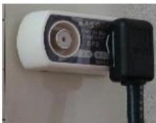
③部屋のテレビアンテナ端子に同軸ケーブルのコネクタで接続します。部屋のアンテナ端子をテレビと共用する必要がある場合は、アンテナ端子を右図のようにテレビ用端子とFMラジオ用端子に分配する分配器（マスプロ FM VU BS 2分配プラグDP2）等を使うこともできます。分岐によって、テレビの受信状況が悪くなる場合はブースターなどの機器が必要になる場合もあります。
